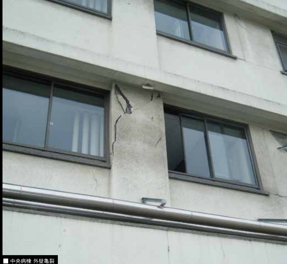
■ 中央病棟 外壁亀裂
